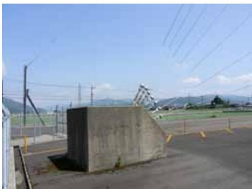
なお、この鉄塔は自立型ではなく、ワイヤーで支えられた支線式鉄塔である。支線は3方向にあり、その下部はコンクリートで杏子に固定されている。
